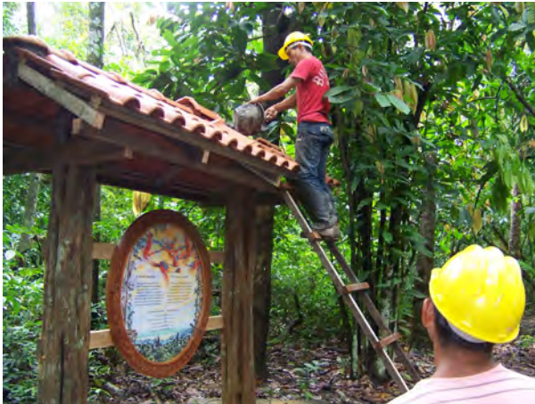
Funcionários trabalhando nos retoques finais dos quiosques. A estrutura foi feita em madeira maciça nativa e recebeu um teto de telhas, visando proteger as placas contra condições climáticas rigorosas e queda de vegetação. O quiosque também é grande o suficiente para abrigar alguns visitantes durante possíveis tempestades. Foto: Chris Mayer.
